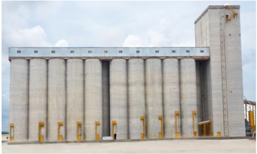
আলোকচিত্র-৫.১ঃ মংলায় নবনির্মিত ৫০ হাজার মেঃ টন ধারণক্ষমতার কনক্রিট গ্রেইন সাইলো
